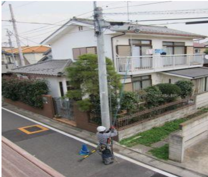
Slika 5 Primjer postavljanja svjetlovodnih kabela putem nadzemne mreže
