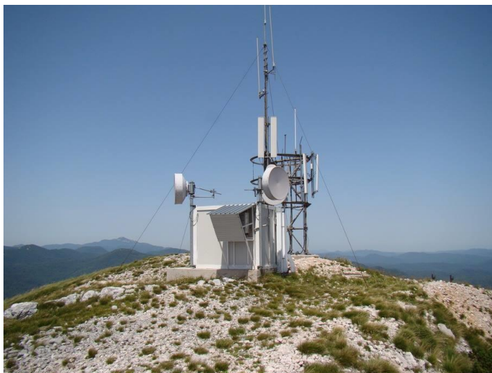
Slika 6 Primjer br. 1 uspostave bežične veze točka-točka koja podrazumijeva postavljanje antena na postojeći ili novi stup
